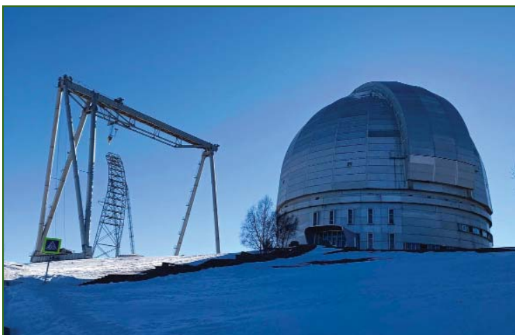
БТА и кран для монтажа зеркала (слева), 2019 г. (Источник: https://mwtravel.ru )
