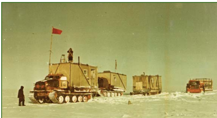
Рис. 5 Астрономические определения местоположения санно-гусеничного поезда (1957 г.) [5]
