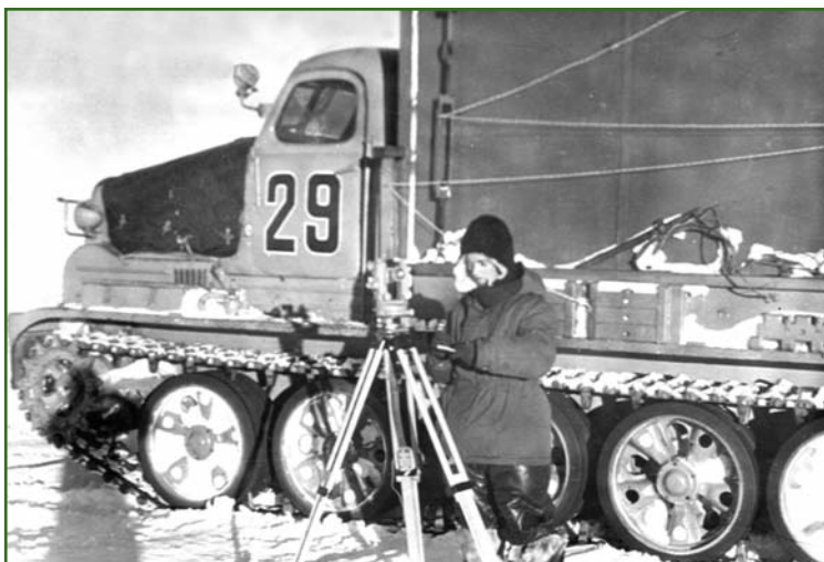
Рис. 7 Астрономические определения по наблюдениям высоты Солнца (у теодолита Г.Е. Лазарев) [7]
