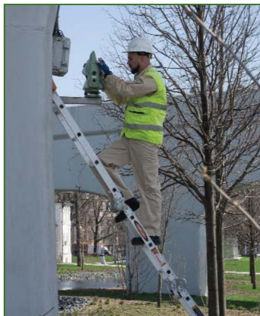
Монтаж электронного тахеометра для наблюдения за деформациями консоли смотровой площадки «Парящий мост»
