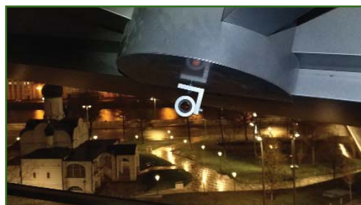
Деформационная марка с L-образным креплением на соединительном узле «Бабочка» каркаса конструкции «Стеклянная кора»
