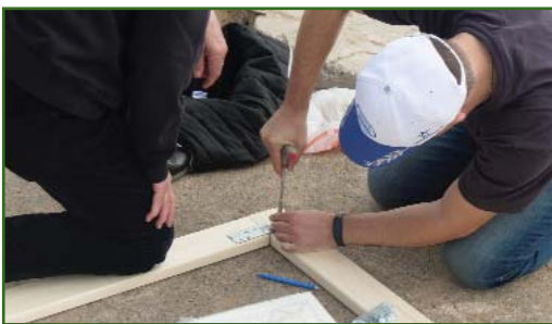
Сборка каркаса щита
