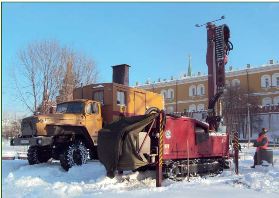
Инженерно-геологические изыскания на площадке для установки памятника Патриарху Гермогену
