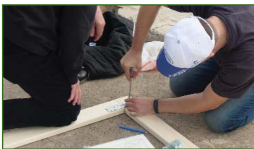
Сборка каркаса щита
