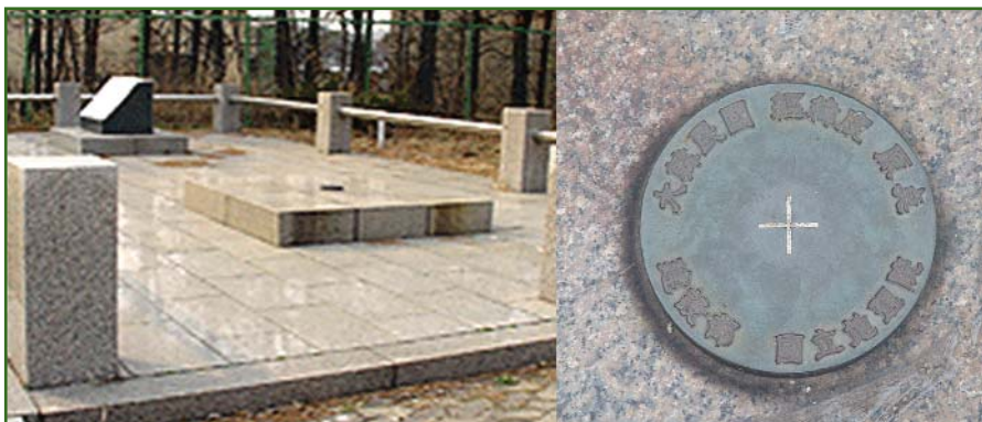
Рис. 3 Исходный пункт южнокорейской геодезической сети [5]
