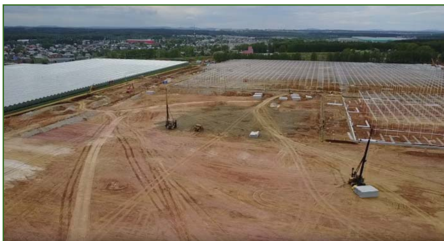
Рис. 1 Общий вид строящегося тепличного комплекса
