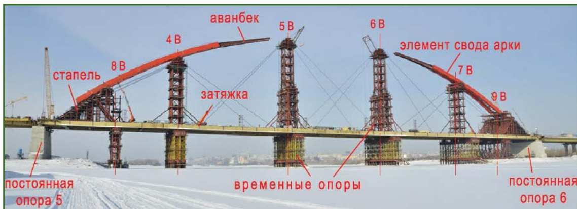
Рис. 2 Процесс монтажа арки Бугринского моста
