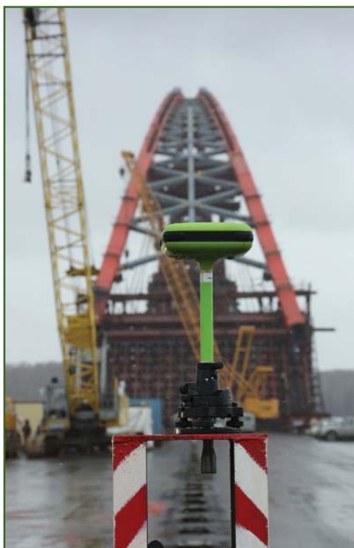
Рис. 6 Базовый приемник, установленный на пункте геодезической сети мостового перехода
