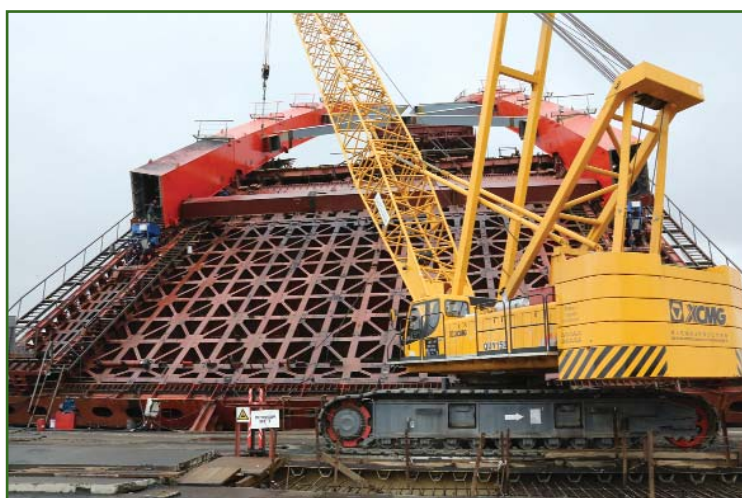
Рис. 4 Надвигка блоков арки на стапеле
