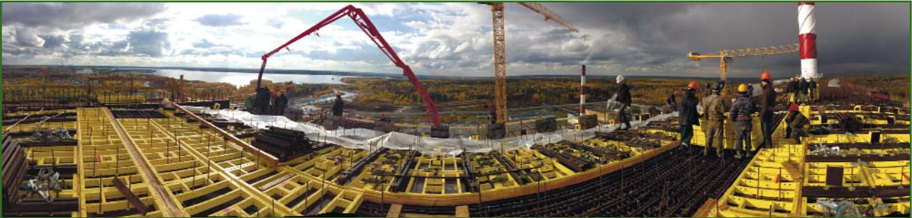
Рис. 5 Панорама свода снаружи (процесс бетонирования)
