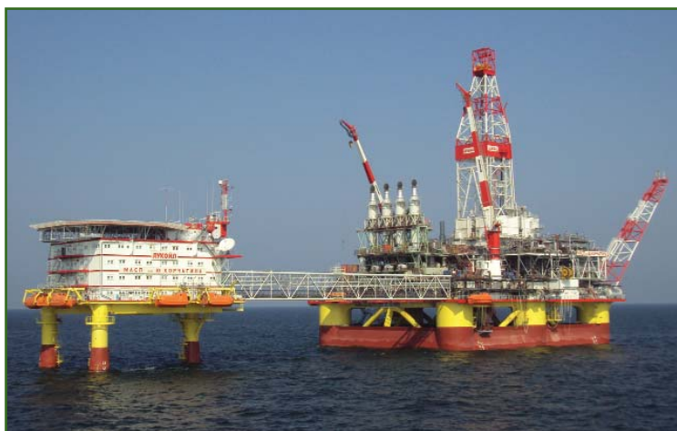
Рис. 1 Морская ледостойкая стационарная платформа на месторождении им. Ю. Корчагина
