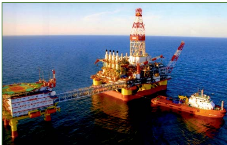
Рис. 1 Морская ледостойкая стационарная платформа на нефтяном месторождении им. Ю. Корчагина
