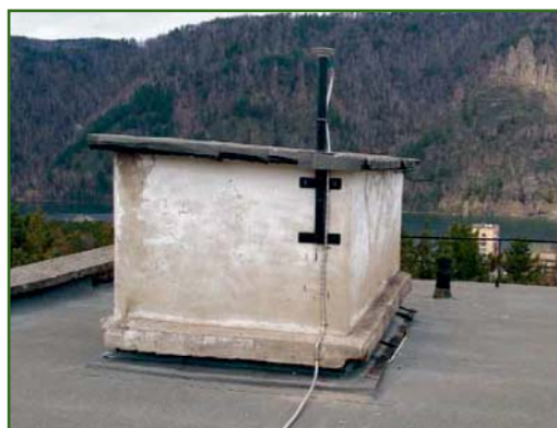
Антенна приемника Leica GRX1200+, установленная на крыше здания
