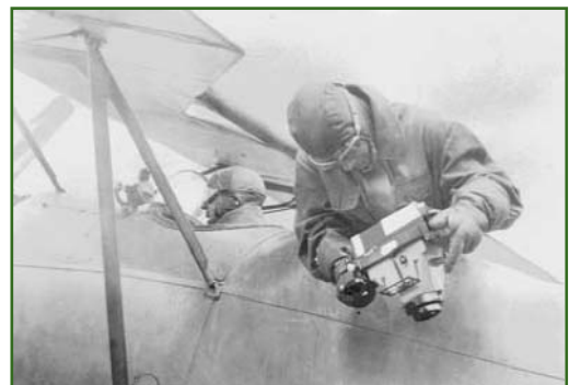
Рис. 6 Аэрофотокамера фирмы Wild C2 (1927)
