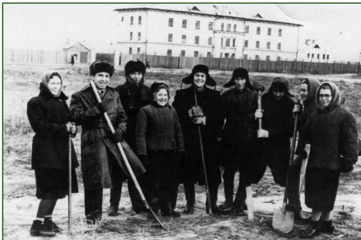
Начало строительства здания техникума
