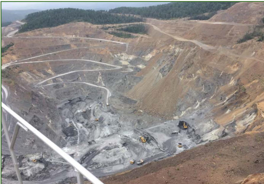
Рис. 1 Общий вид карьера месторождения «Березитовый рудник»
