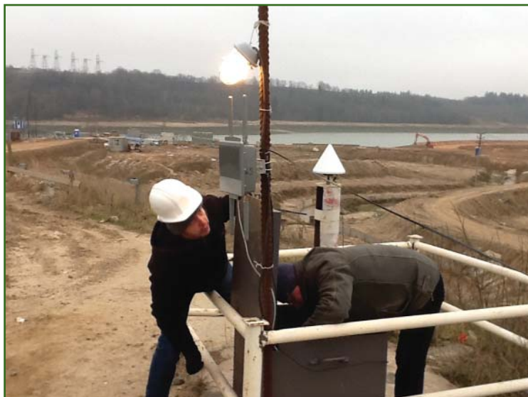
Рис. 2 Монтаж оборудования WiFi на объекте мониторинга сотрудниками компании JAVAD GNSS
