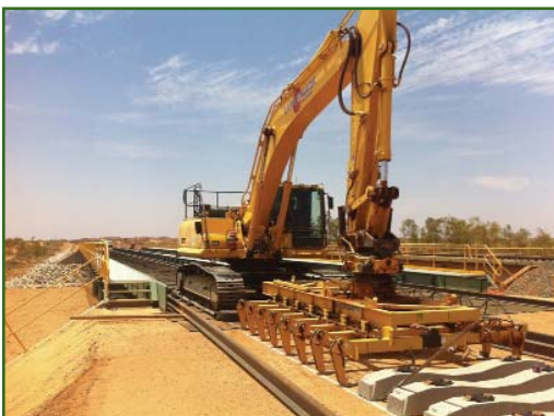
Рис. 1 Строительство железнодорожного полотна
