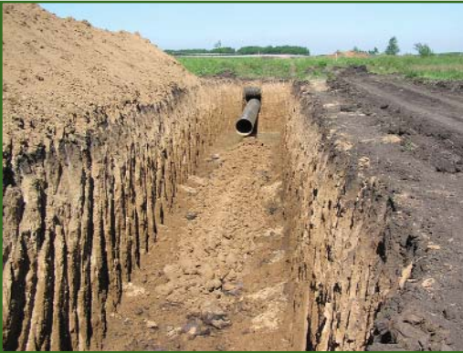
Рис. 5 Раскопанная траншея
