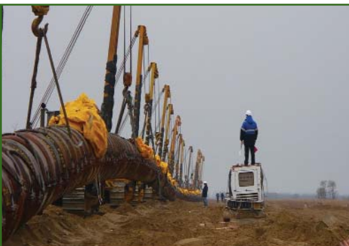
Рис. 6 Укладка трубы
