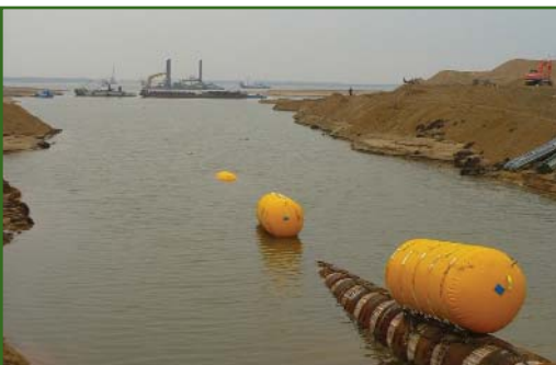
Рис. 7 Балластировка подводного перехода
