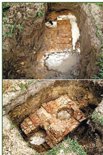
Рис. 4 Фундаменты полевой обсерватории в деревне Белин
