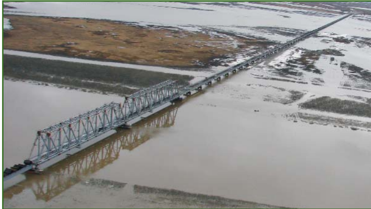
Рис. 2 Общий вид железнодорожного моста через р. Юрибей
