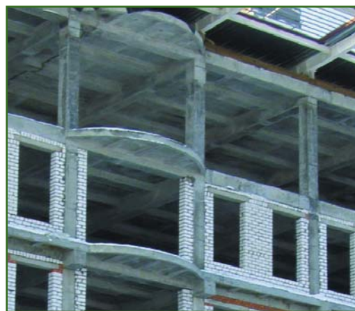
Рис. 1 Фасад строящегося здания в городе Чебоксары
