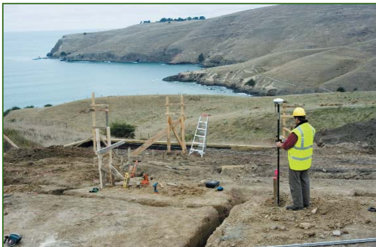
Рис. 3 Спутниковый приемник Trimble R8 GNSS в качестве подвижной станции
